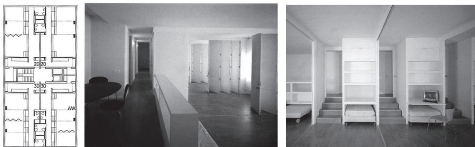
Por último, la propuesta de Gio Ponti para los apartamentos de los empleados de correos, sitúa la transformación del espacio en el simple giro de un panel pivotante sobre un eje excéntrico (figura 41).
